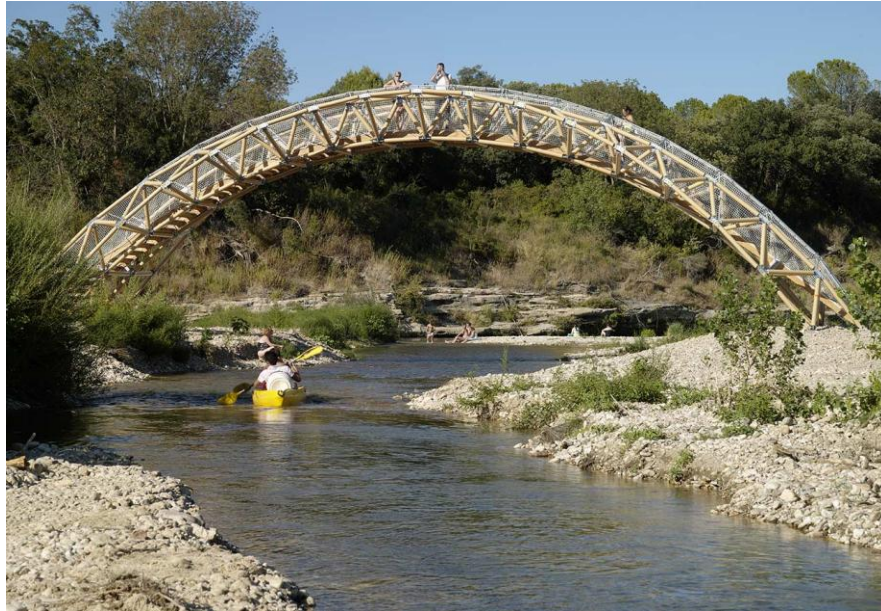
Pont en carton (mais pas seulement...) réalisé par Shigeru Ban sur le Gardon (2007, portée 20m, testé avec 1,5 tonne)
